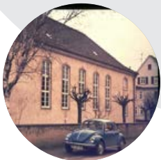
Schulstart im Gemeindehaus Betzingen → 1973
