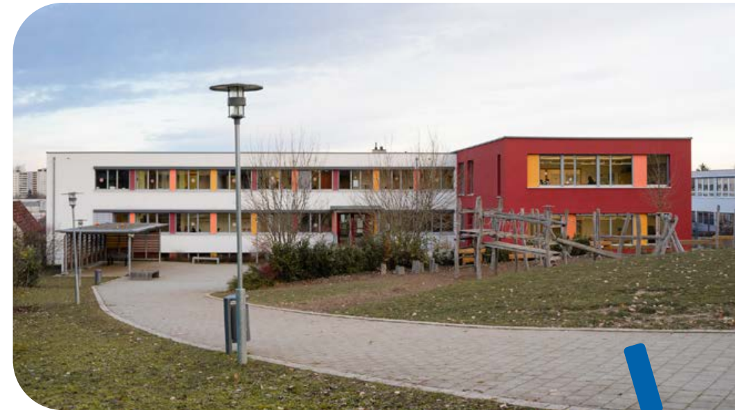
Schulgebäude in Laisen
