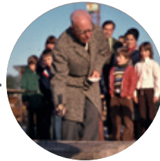
Prof. Reininghaus Grundsteinlegung Königsträßle → 1976
