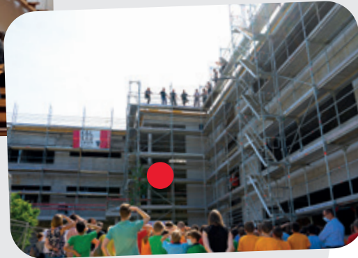
Richtfest des neuen Schulgebäudes
